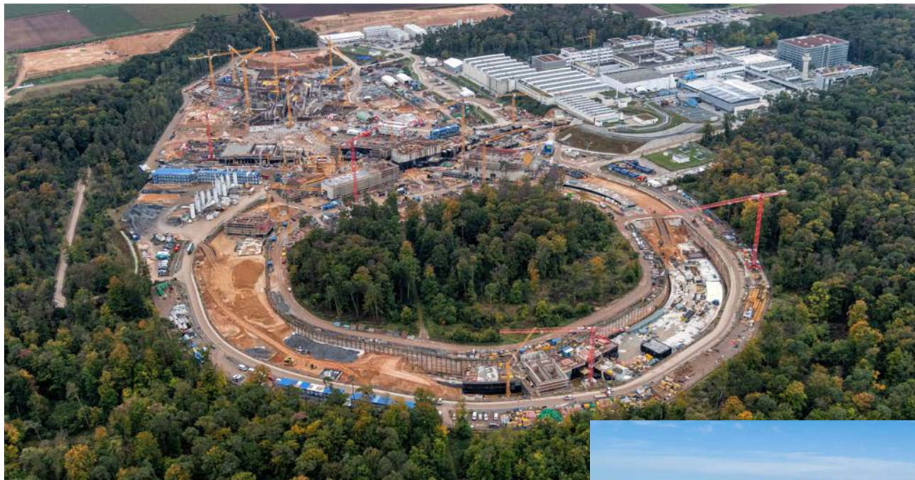
FAIR- Construction Site (October 2021)
