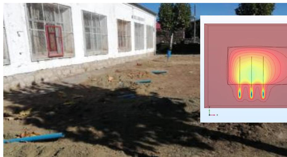
**Extracciones lineales insertadas desde el exterior de la edificación. Tuberías perforadas**
