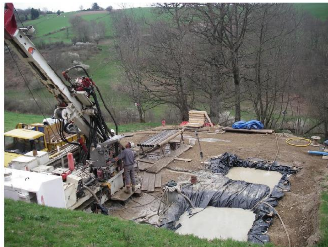
Sondage A89 (2007) incliné de 45° de 125 ml (surface plateforme estimée : 12 x 12 m soit environ 150 m 2 )
