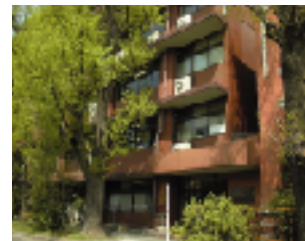
御殿下グランド側から見た本館
