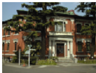
医学部附属病院側から見た東館
