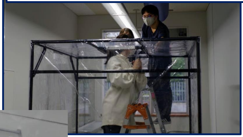
製作開始時(クリーンルームの設置)
